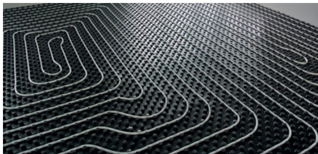
Рисунок 9: Укладка труб для теплого пола
