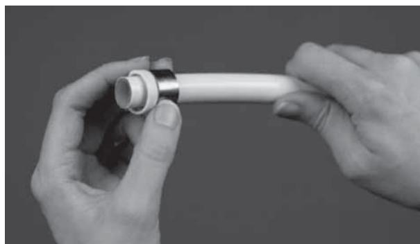
2. Вставьте подвижную гильзу FV A-PRESS на трубу
